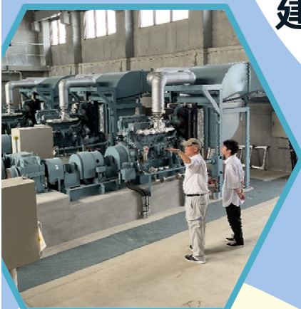
現地見学（排水機場）
