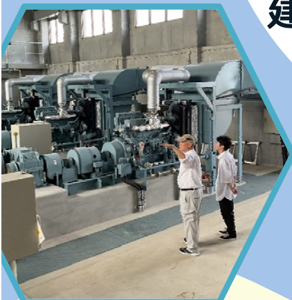
現地見学（排水機場）
