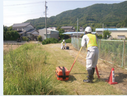
基準点測量 (測量実施の基礎となる 基準点の位置を定めます)
